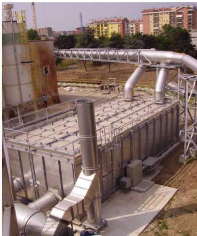
**Fig.3.1.** Vista di un reattore biologico biotrickling filter.
