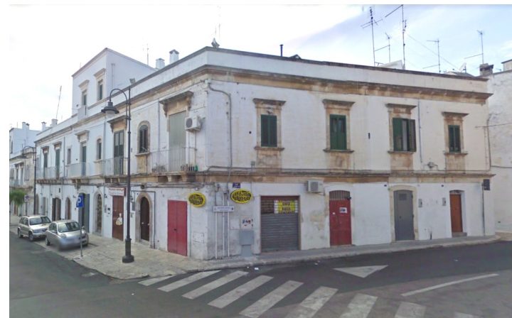
edifici in Via Donizetti
