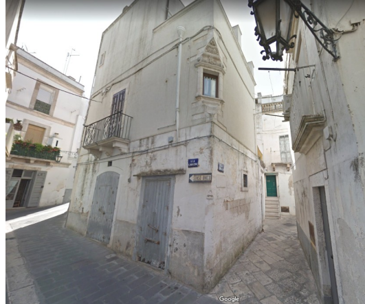
edificio in Via Manzoni
