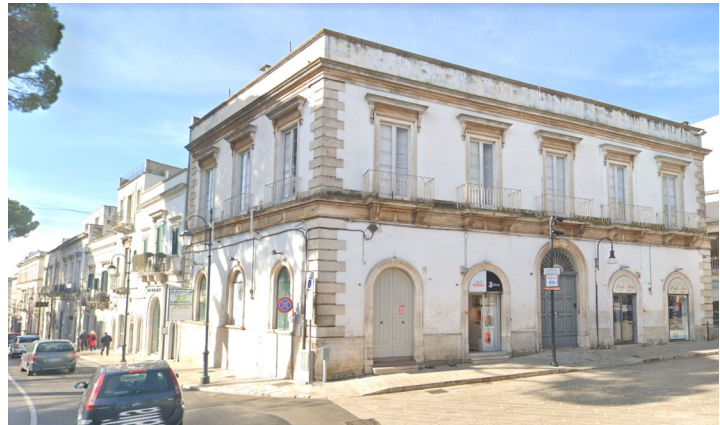
edifici in Corso Italia
